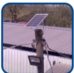
Nos postes de iluminação dos canteiros foram instaladas placas fotovoltaicas que captam a luz do sol durante o dia e geram energia durante a noite, economizando o consumo de energia na rede.
