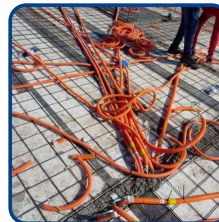
Para redução de resíduos, assim como, montagem mais rápida e eficiente, garantia de padronização e controle de qualidade, o Grupo ADN adota *kits* pré-moldados para instalações elétricas e hidráulicas.
