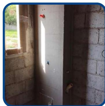
O Grupo ADN tem adotado *shafts* pré-moldados para os banheiros e cozinha dos empreendimentos e muros de placas pré-moldadas para isolamento dos terrenos que já ficam posteriormente no empreendimento, gerando menos resíduo.
