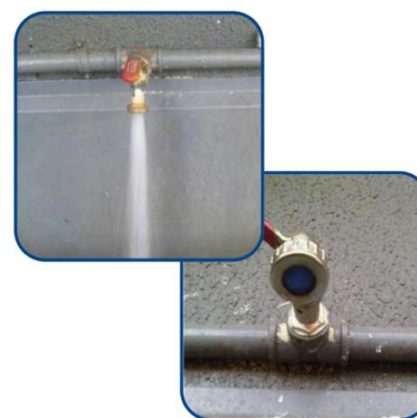
Os dispositivos redutores de vazão são instalados na parte de dentro das torneiras da obra para limitar e controlar a quantidade de água neste ponto de consumo, reduzindo os desperdícios sem comprometer a eficiência do uso.
