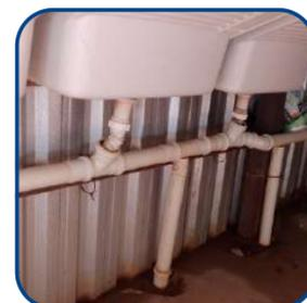
A água cinza coletada nas pias dos vestiários tem sido desviada para uso nas descargas dos mictórios.
