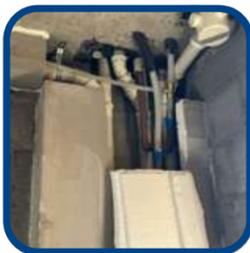
A substituição do tubo PEX pelo PERT foi possível porque ambos possuem mesmas dimensões, permitindo o uso das mesmas conexões. Além disso, o PERT apresenta boa resistência à temperatura, é flexível, tem custo menor e é fabricado nacionalmente. Embora seja produzido com matéria-prima virgem, é reciclável, contribuindo para a redução do impacto ambiental.
