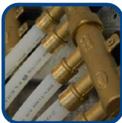
As tubulações dos empreendimentos da linha UP foram substituídos de PVC para PEX/PERT. Essa mudança permitiu reduzir o uso de sancas nos apartamento e o custo final de execução. Por ser um material flexível, o PEX/PERT permite reduzir a quantidade de conexões necessárias, reduz o risco de vazamentos e facilita a execução em obras.
