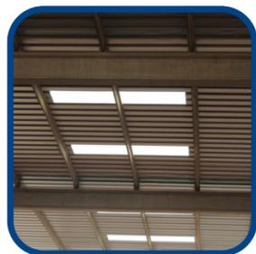
Trechos das telhas convencionais são substituídas por telhas translúcidas para permitir a entrada de luz natural, reduzindo a demanda por dispositivos de iluminação.
