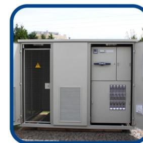
A utilização de geradores a óleo diesel tem sido substituída nas obras por postos de transformação com aprovação prévia em concessionárias de energia.
