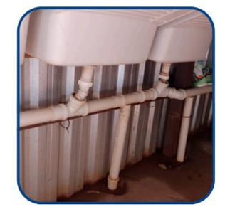
A água cinza coletada nas pias dos vestiários tem sido desviada para uso nas descargas dos mictórios.
