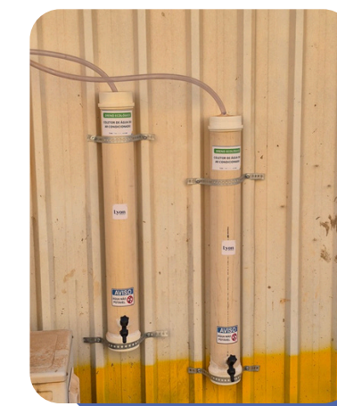
▶ Reutilização de água do ar condicionado
