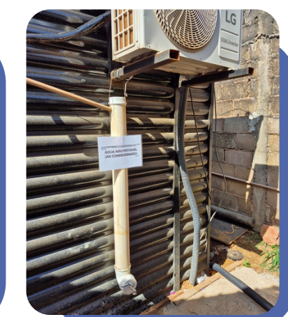
▶ Reutilização de água do ar condicionado
