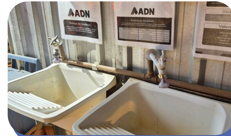
▶ Redutor de vazão nas torneiras
