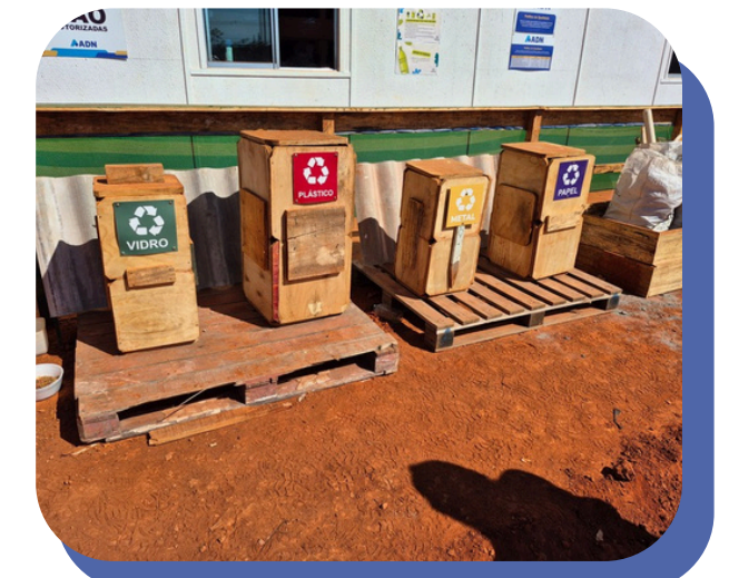
▶ Reaproveitamento das formas de fundação para coleta seletiva
